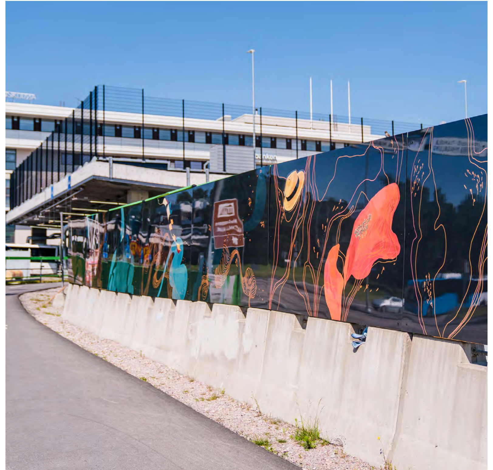
Tuultenristin taideaita, Ilona Partanen (2021) Espoon Tapiolassa sijaitsevaan työmaa-aitaan toteutetun teoksen visuaalinen maailma siirtyy pysyvänä taiteena myöhemmin valmistuvien asuintalojen auloihin. Teoksen lähtökohtana on ollut löytää itä-, etelä- ja länsituulelle oma visuaalinen luonteensa. Työmaa-aidan teos jää esilläolonsa jälkeen osaksi EMMA:n kokoelmaa, ja teosta on jatkossa mahdollista tuoda esille myös muualla Espoon julkisessa tilassa. Digitaalinen tuloste, alumiinikomposiittilevy, 1,6 x 88 m. Kuva: Paula Virta / Espoon modernin taiteen museo EMMA
