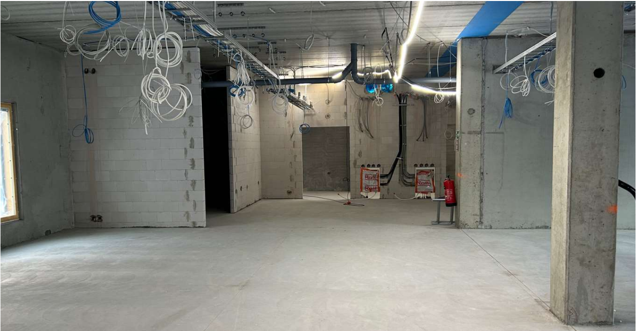
Pohjakerroksen muuratut väliseinät on tehty ja talotekniikka-asennukset ovat käynnissä
