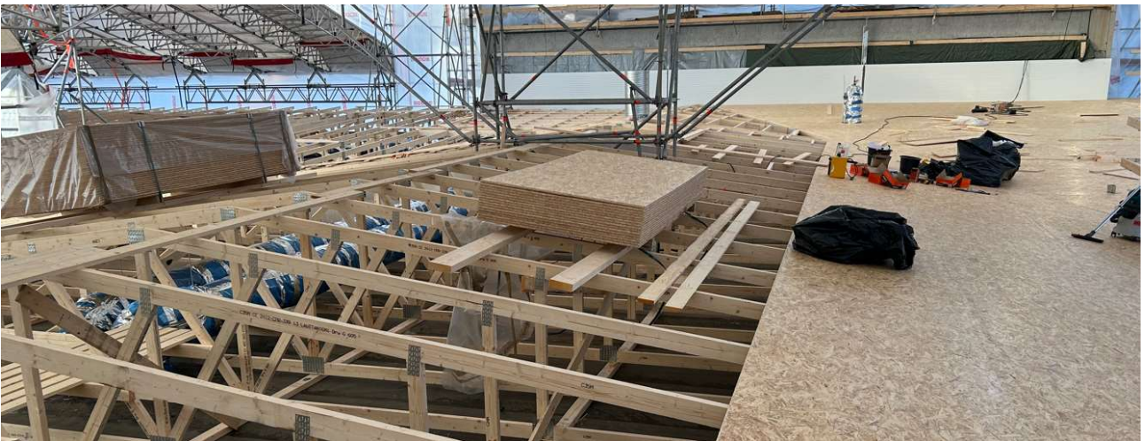
Vesikaton umpeen levytys on käynnissä
