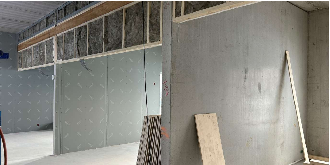
Levyseinät on aloitettu
