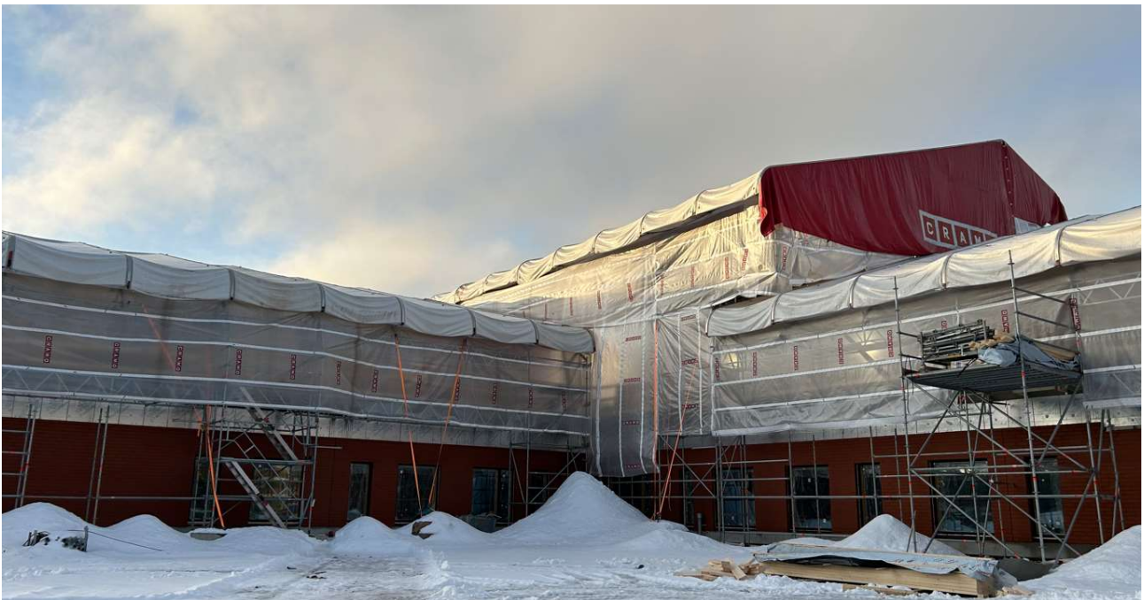
Töitä tehdään sääsuojan alla
