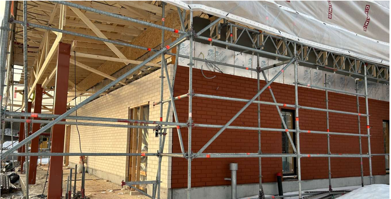
Julkisivumuuraukset ovat käynnissä
