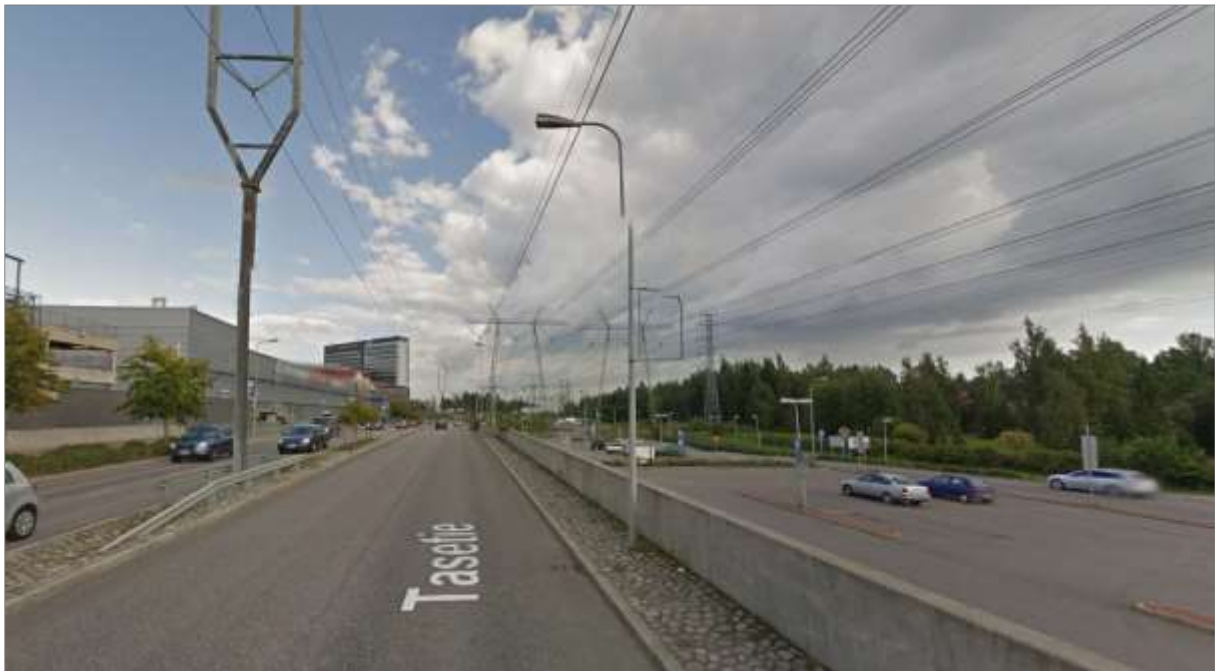
Kuva 18 Esimerkki pysäköinnin järjestämisestä korkeajännitelinjalle alle (lähde Google Street View)
