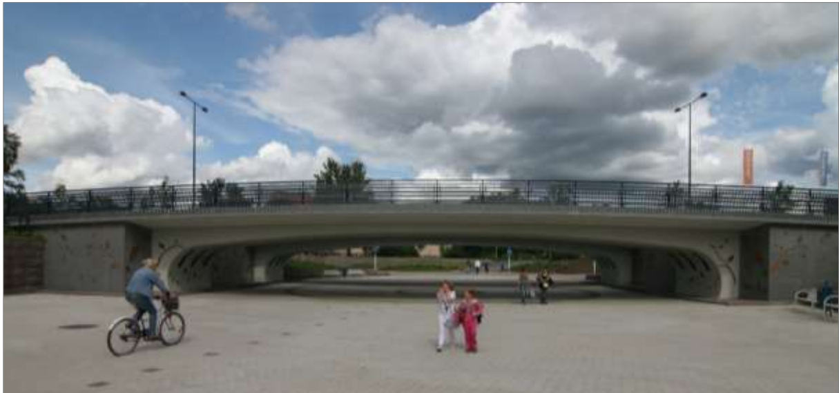
Kuva 22 Viertolan alikulku Keravalla
